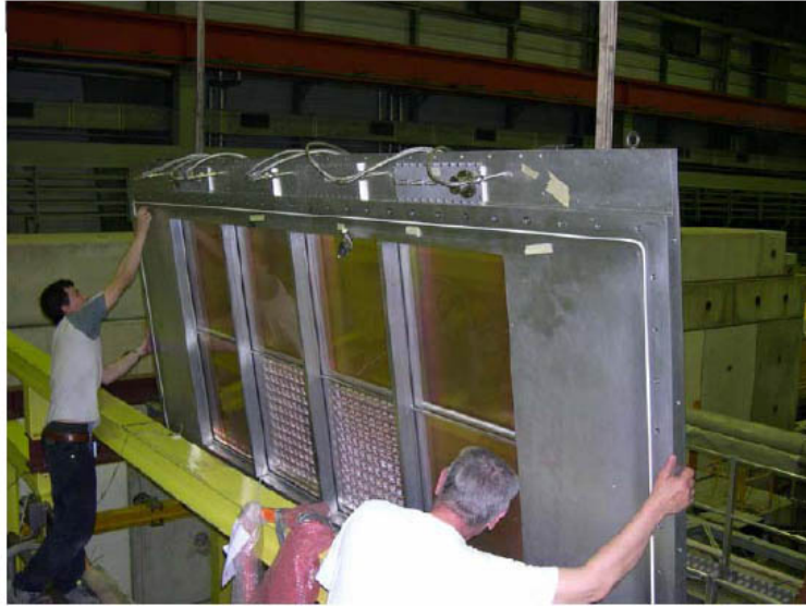
Figura 2.20: Fasi dell'installazione dei nuovi gruppi ottici del RICH-1
